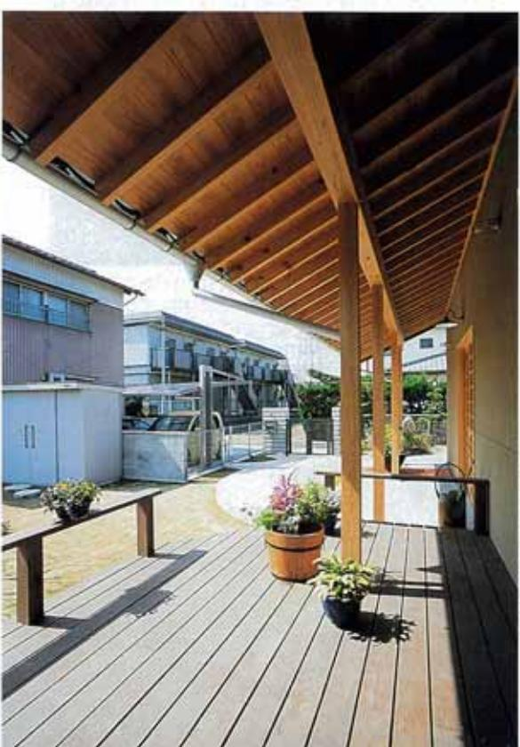
(右)深く垂らした軒で、夏の強い日差しや雨が吹き込むのを防ぎます (左)エントランスからしっとりとした風情が漂います。スロープは、車椅子でもスムーズに通れるように緩やかな角度に設定【屋根】日本瓦葺き【外壁】防火サイディングアクリルリシン吹き付け
